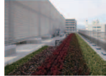
放送会館屋上緑化
