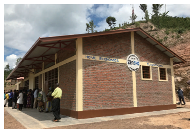
完成した 家庭科教室の外観
