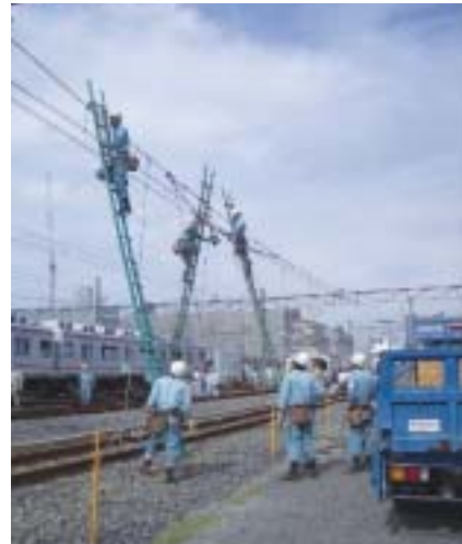
事故復旧総合訓練の様子
