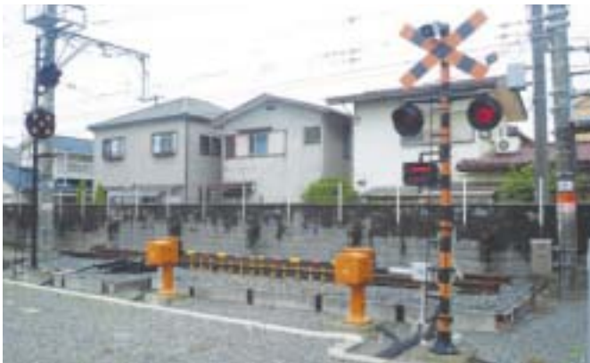
研修用踏切保安設備
