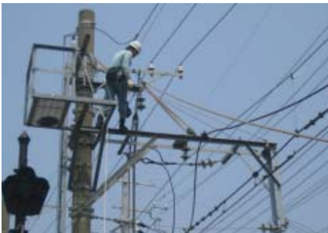
電路柱上作業訓練風景
