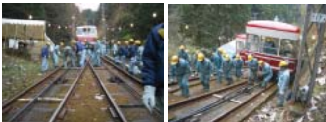
ケーブル張替えの様子
