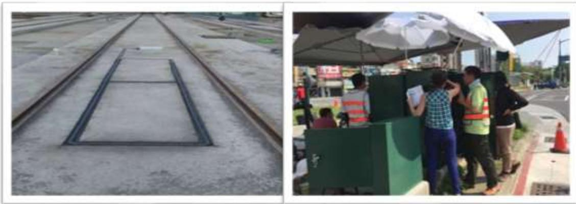
迴圈(Loop)安裝、路口交通控制器(TR)安裝
