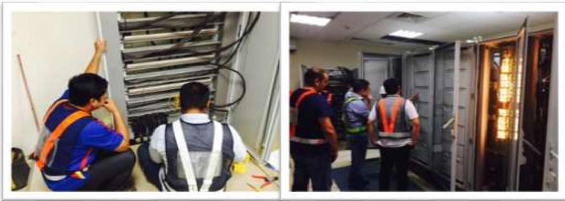
聯鎖系統配線盤接線及測試
