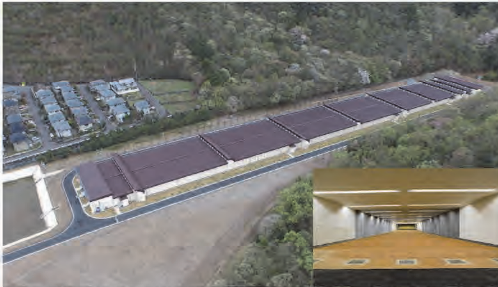
完成した射撃場全景(前田建設工業(株)提供)(左上) 射撃場内部 表面は無石土(右下)
