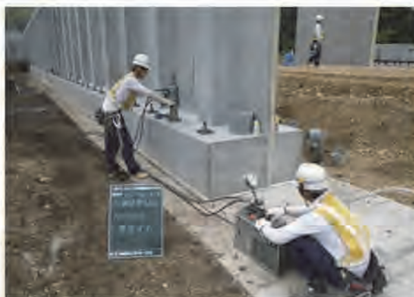
柱・壁と基礎コンクリートのボルト連結
