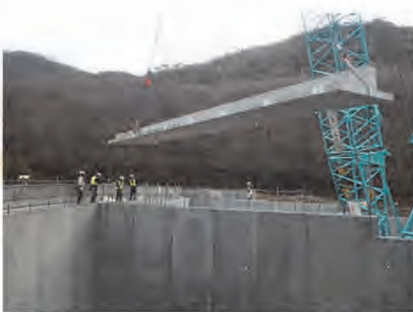
200 t クレーンによる梁(26.8 t)の吊込
