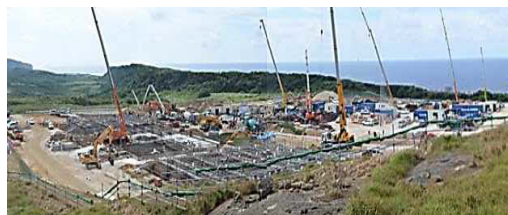
現在建設中の与那国駐屯地（仮称）
