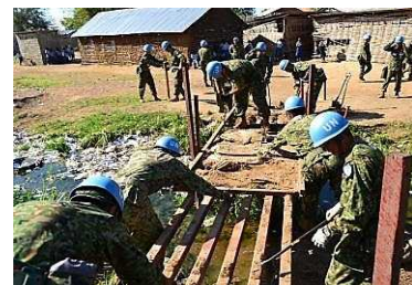
【南スーダンPKOにおける道路整備】
