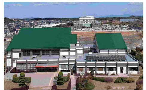
公共用施設の一例(体育館)
