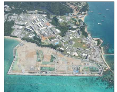
普天間飛行場代替施設の建設
