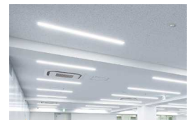
LED照明器具へ更新
