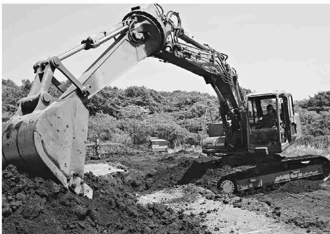
84RR射座を改修整備する12施(相馬原)
