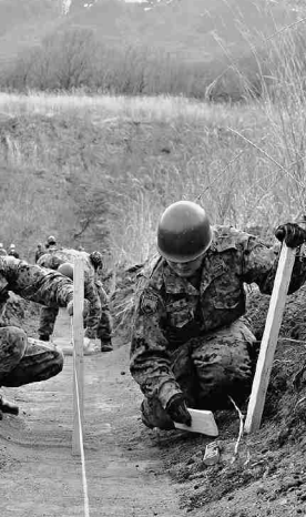
U字溝設置位置の平床作業
