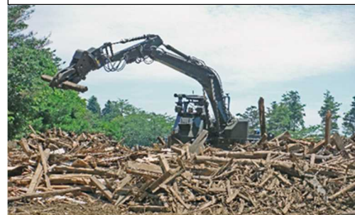
遠隔操縦作業 (把持装置による通路啓開)
