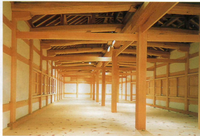
県内産の木材で施工
