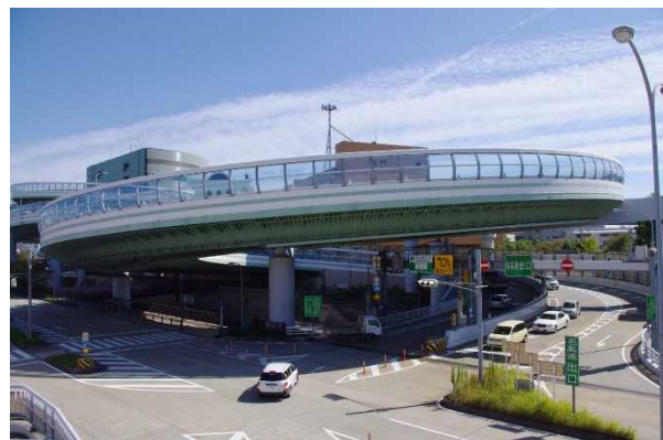
ランプと一般道接続部
