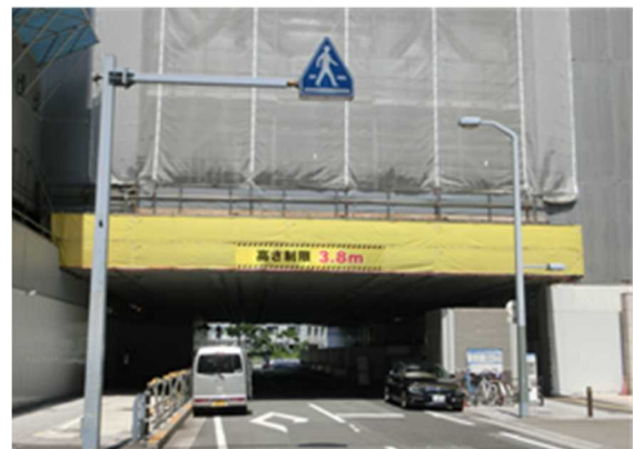
道路上空利用部（工事中）
