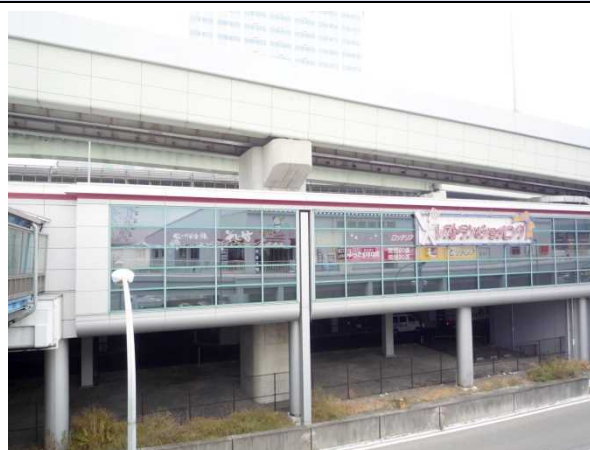
道路下の商業施設
