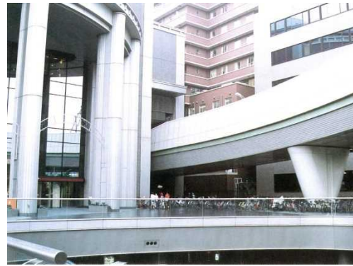
OCAT に進入する高速道路
