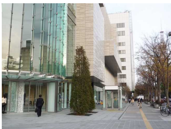
地下歩道地上部と建物
