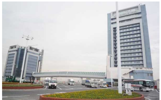
泉大津PAと一体建物
