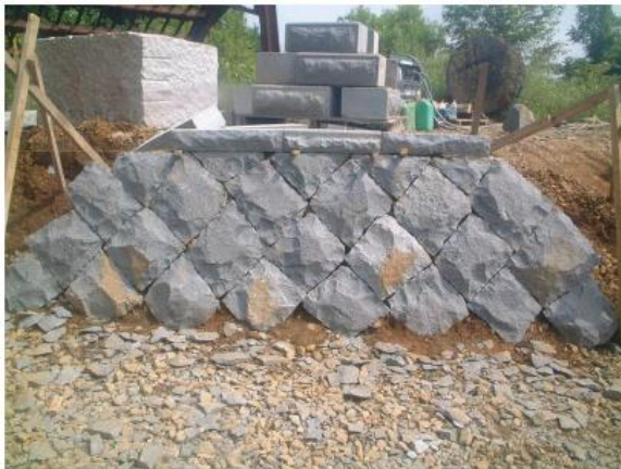
護岸の試験施工の様子
