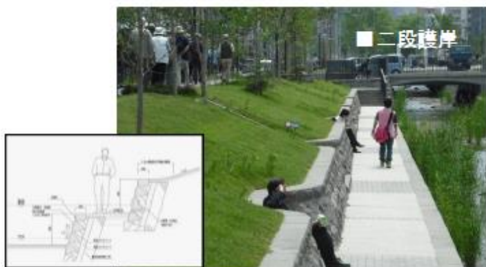
二段護岸による整備
