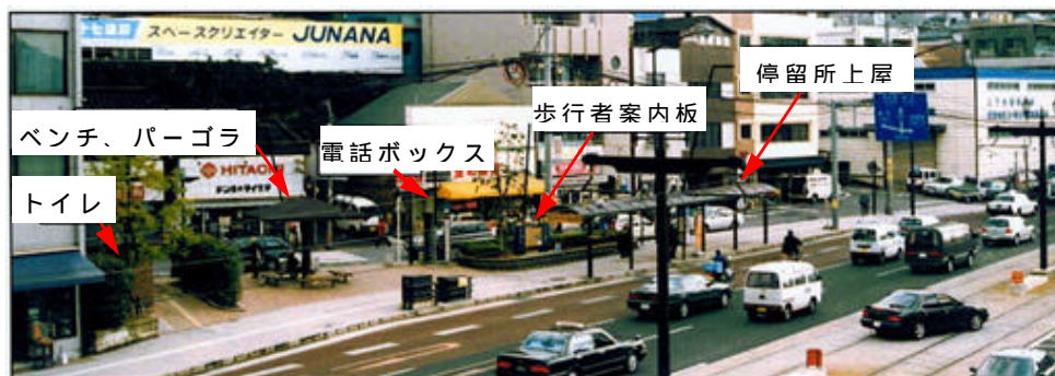
図 4-4-2 多機能な停留所の整備を行った事例
