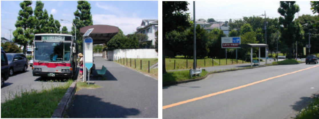
写真 4-2-1 神奈川県横浜市（植樹帯の幅員を活用してバスベイを設置）
