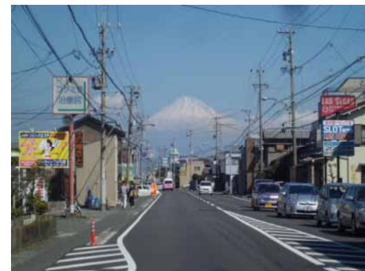
< 美観を損ねる電柱・電線 >
