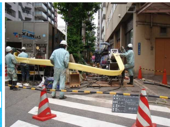
ポリエチレン管引き込み状況(イメージ)
