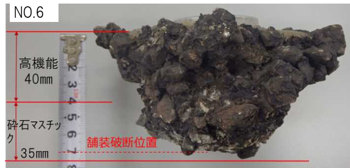
【アンカー部詳細写真】
