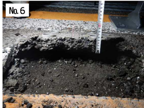
【舗装盛り部断面写真】
