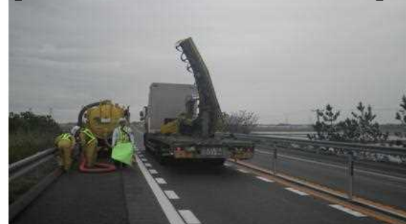
[標識車後方より作業箇所]
