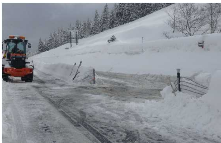
人力除雪等によりワイヤロープ区間で開口部を確保した事例
