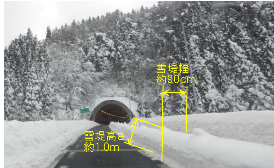
<磐越道 三川～安田 ラバーポール 1/12朝 大雪直後>
