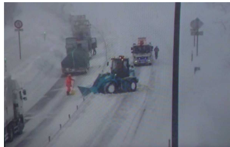
(参考) ラバーポール区間でトラクタショベルにより開口部を確保した事例
