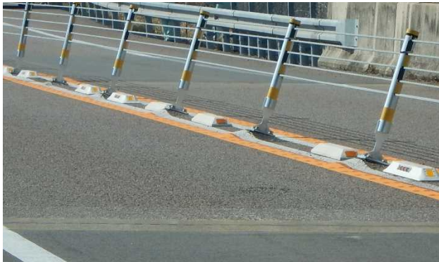
【橋梁部舗装状況写真】
