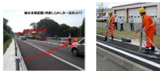
インシデント時の滞留状況 開口部設置状況（ワイヤロープ）
