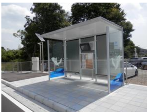
図 5-24 上屋（バスシェルター）の設置 19
