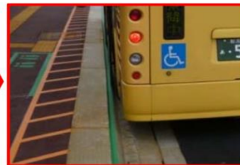
施工後 平均隔離 10cm
