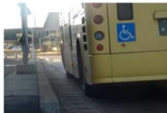
施工前 平均隔離 50cm
