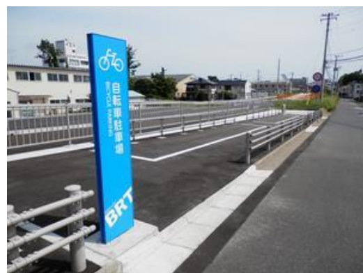
図 5-25 自転車駐車場の整備 19
