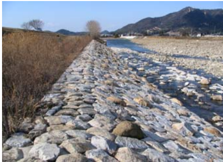
写真-2-6 香川県 土器川 低水護岸部が巻天端である
