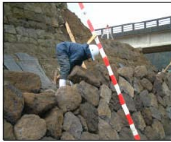
写真-3-1 人力による施工
