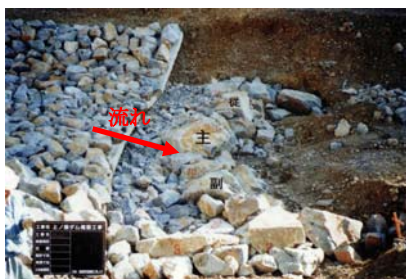
写真-1-8 床固工の全景
