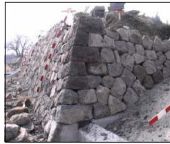
写真-3-2 隅角部の算木積処理
