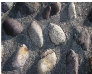
写真-2-17 山梨県・塩川・玉石護岸の拡大写真
