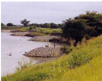
写真-2-7 熊本県 菊池川 水制上部が巻天端となっている
