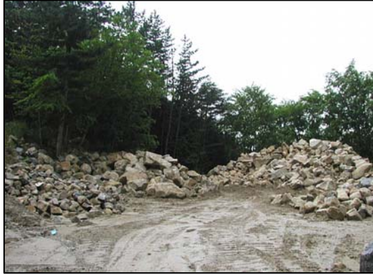
写真-4-2 工事で発生した石材のストック状況
