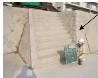
写真-1-6 広島県・猿候川に設けられた階段護岸
