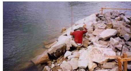
写真-1-1 工事機器の発達により巨石を利用する河川工事も増えてきている
