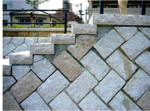
図-3-7 美しい隅角部の処理の例
