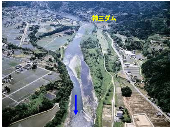
写真① 神通川 22. 3k 大沢野大橋から上流を望む
