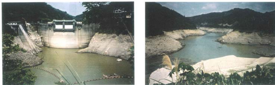
図 5-6 室牧ダム貯水池の様子
