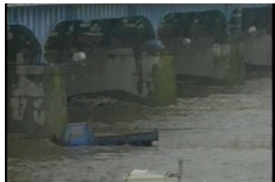
高水敷に取り残されたトラック
