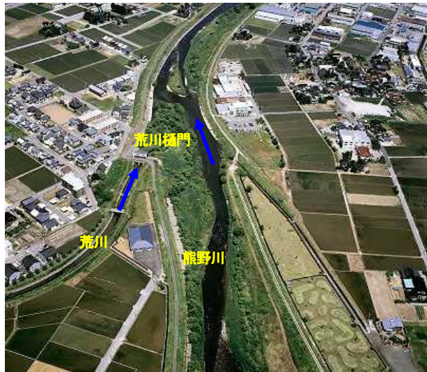
写真⑧ 荒川樋門付近
