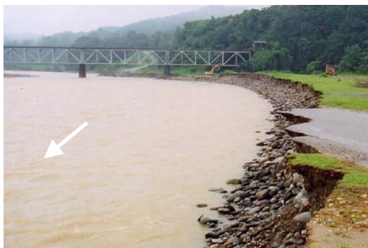
河岸侵食状況 (富山市城生)
