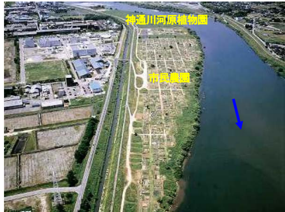
写真③ 神通川 4.0k 中島大橋上流から上流を望む
