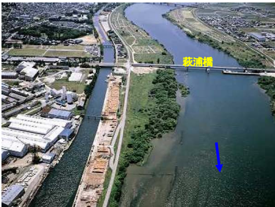
写真② 神通川 1.0k 萩浦橋下流から上流を望む
