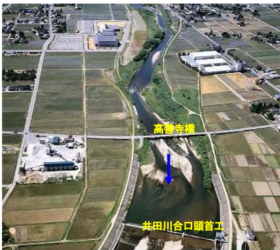
写真⑭ 井田川 12. 0k 井田川合口頭首工から上流を望む
