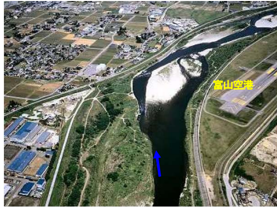
写真⑨ 神通川 15.2k 新保大橋から下流を望む
