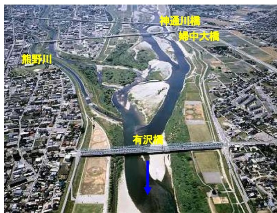
写真⑥ 神通川 9.0k 有沢橋下流から上流を望む
