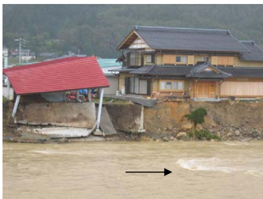
上流部被災状況 (高山市上切町)
