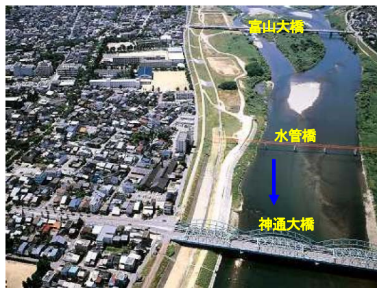
写真⑤ 神通川 7.0k 神通大橋下流から上流を望む
