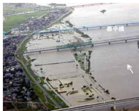
H16.7 洪水：冠水した河川敷公園
