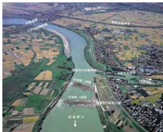
沢海床固工と小阿賀野川
