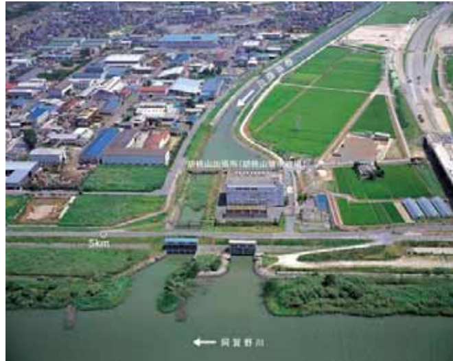
胡桃山排水機場
