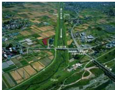
湯川放水路合流点付近
