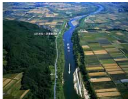
山科地点付近(阿賀川 4k～5k) 【出典：阿賀川河川事務所資料】
