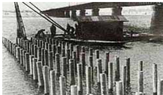
第 2 期改修工事の様子
