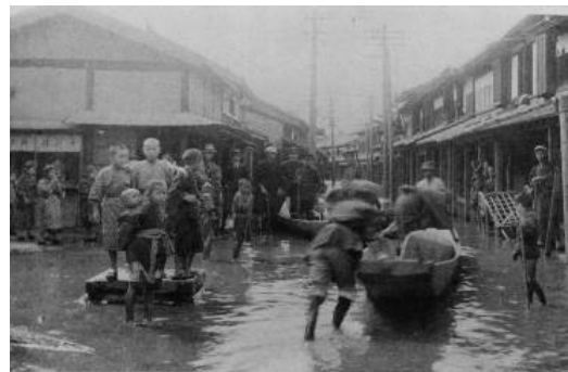
T2.8 洪水：木津切れにより冠水した横越町
