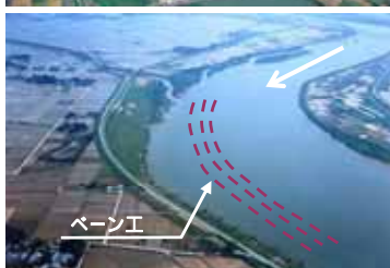
水衝部対策箇所
