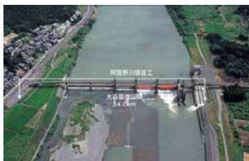
阿賀野川頭首工
