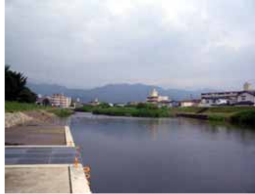
旧湯川分派地点付近
