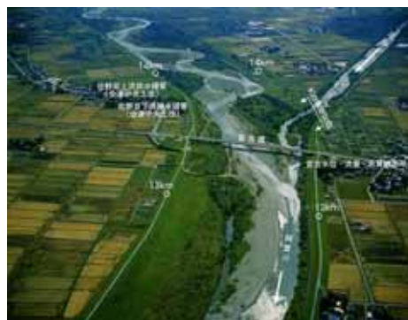
宮川放水路合流点付近
