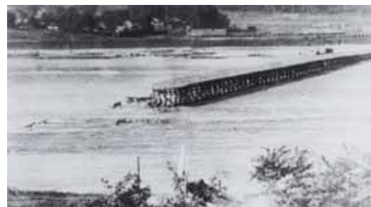
S33.9 洪水：阿賀野川下流部松浜橋流出
