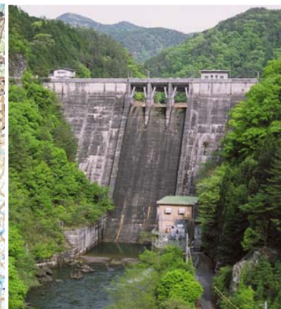
小阪部川ダム(S30年度完成) 〔農水、上水、発電〕
