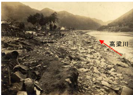
③高梁川左岸の被災状況（高梁市）
