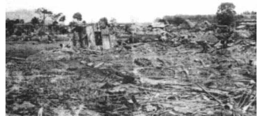
真備町川辺字片原の家屋倒壊状況 (現高梁川右岸 15K 付近 M26.11.1 撮影)
