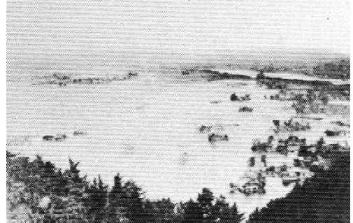
倉敷市西阿知町中島の氾濫状況 (現高梁川左岸 5~7K 付近 M26.10.29 撮影)
