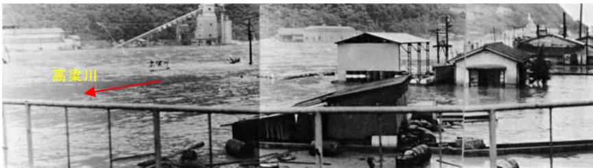
③高梁市森脇付近の氾濫状況
