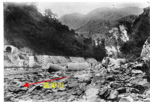
④J R 伯備線井倉駅付近の鉄橋流失状況
