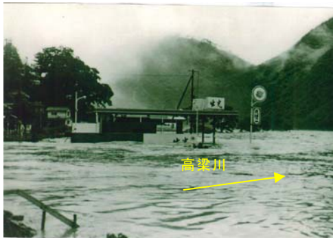
①高梁市の氾濫状況
