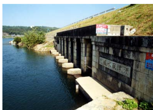
酒津取水樋門(T13完成)
