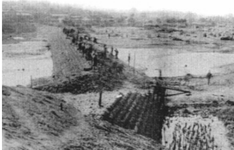
真備町川辺の堤防決壊状況 (現高梁川右岸 15K 付近 M26.11.1 撮影)
