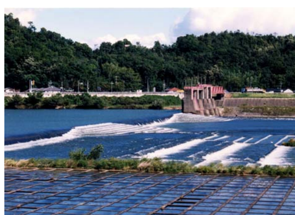
湛井堰（階段式の魚道）
