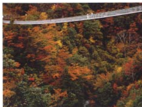
【梅の木轟公園吊橋】
