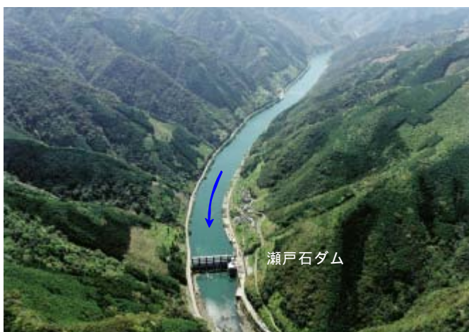
【球磨川 28k900 付近の瀬戸石ダムと湛水域の状況】
