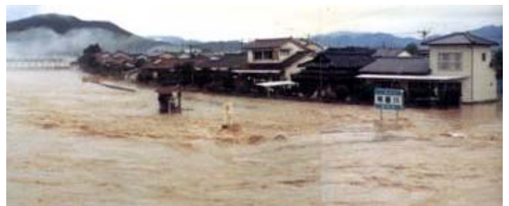
特殊堤を越えた氾濫状況（人吉市上薩摩瀬町）
