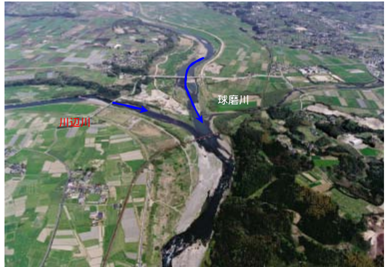
【球磨川・川辺川合流付近河道の状況】
