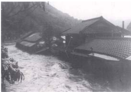
中流部の浸水状況（球磨村神瀬地区）
