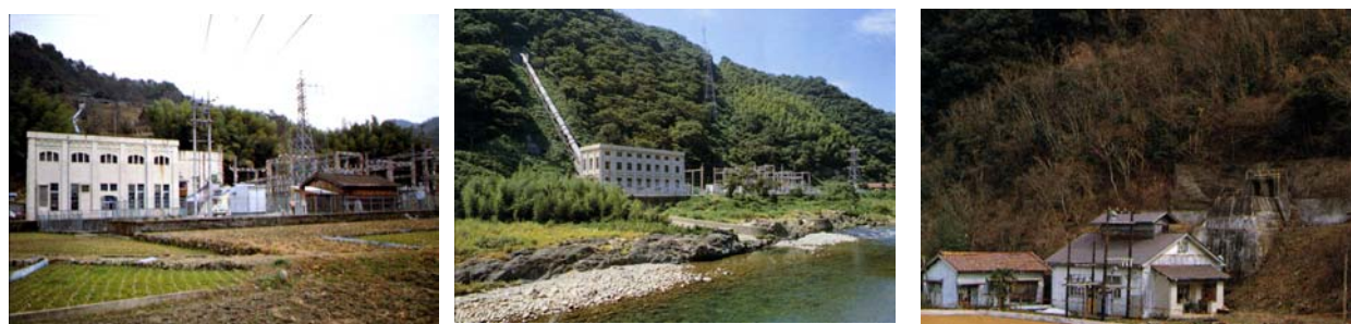
図-5.3 高津川水系の水力発電所（左：豊川発電所、中：日原発電所、右：柿木発電所）
