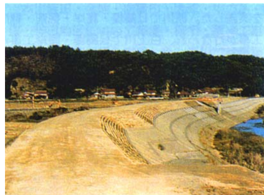
図-4.13 白上川堤防の施工状況(S55)
