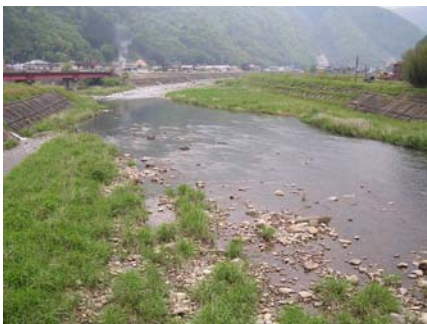
図-2.10 吉賀町六日市八王子橋上流方面
