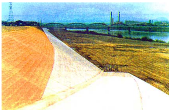
図-4.12 高津地区護岸の施工状況(S54)
