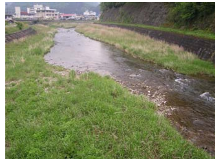
図-2.11 吉賀町六日市新抜月橋上流方面
