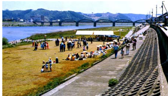
図-2.17 高角橋下流の高水敷の利用状況
