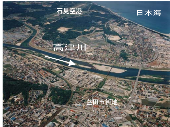
図-2.4 高津川下流部
