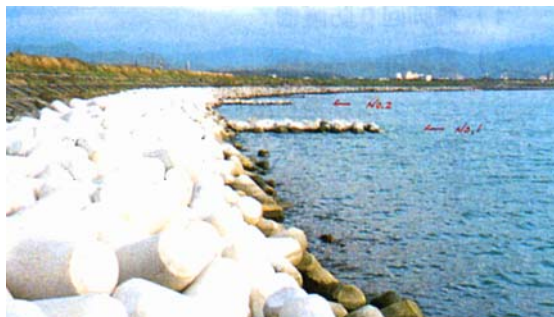
中の島水制工事
