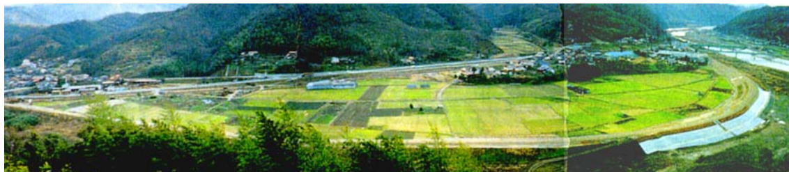
神田地区引堤工事
