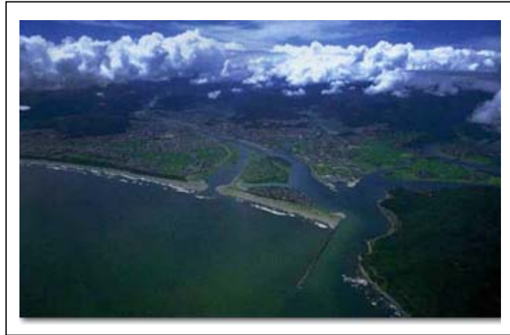
五ヶ瀬川下流部（延岡市 河口部より上流を望む）
