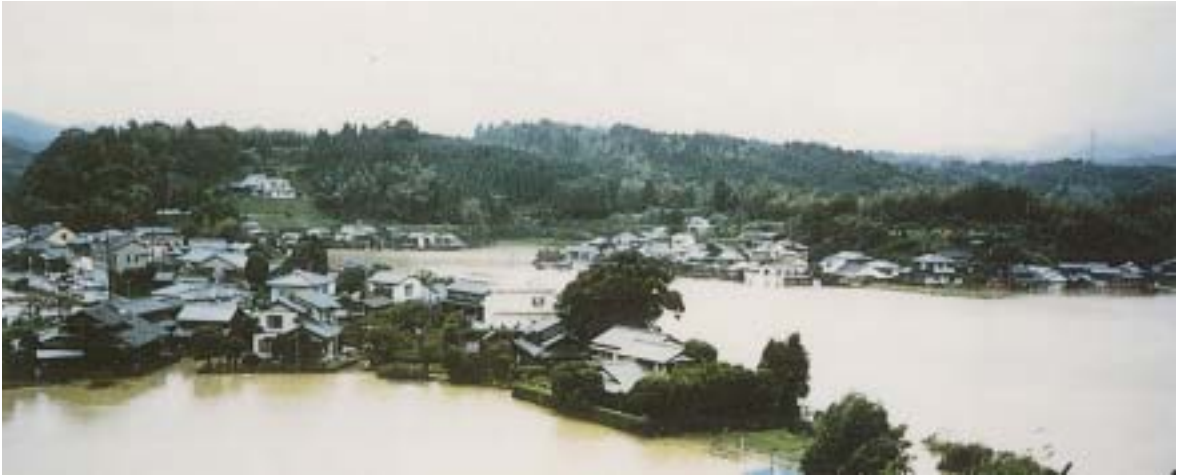
五ヶ瀬川左岸 延岡市小峰町(6k800) 浸水状況
