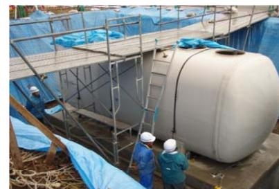
工場製作型極小規模処理施設
