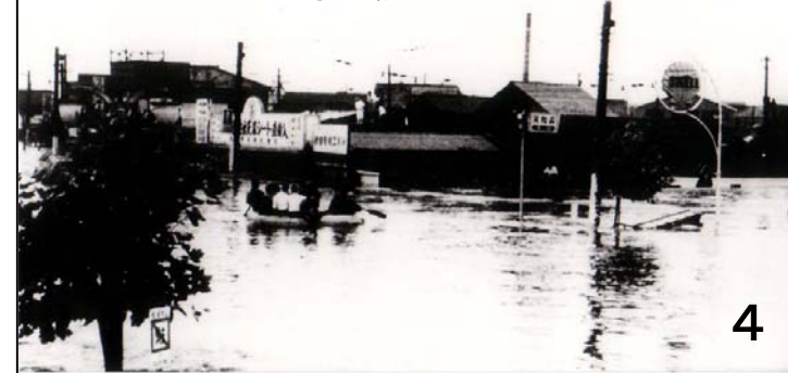
S24キティ台風時の浸水状況
