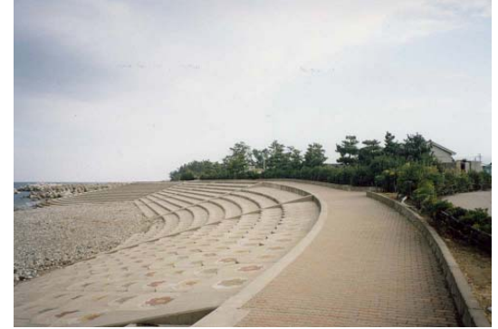
緩傾斜堤 富山県入善町
