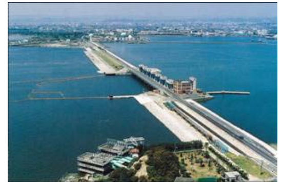
樋門 岡山県岡山市
