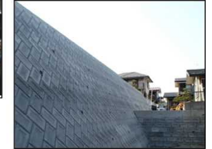
東日本大震災における災害関連地域防災がけ崩れ対策事業(特例) 実施事例
