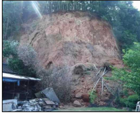
自然斜面崩壊状況（熊本県益城町）
