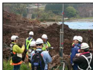
緊急消防援助隊との打合せ状況
