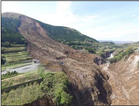
大規模な崩壊事例（阿蘇大橋地区）
