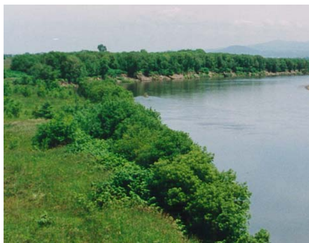
奈井江大橋 (KP76.80付近)
