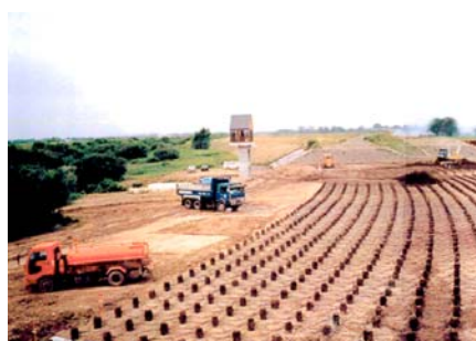
パイルネット工法
