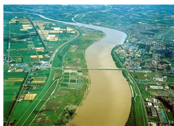
石狩大橋 (KP26.60) 付近
