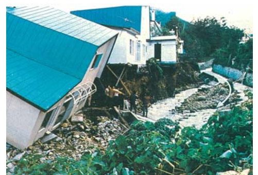
豊平川支川野々沢川の 河岸決壊による民家倒壊
