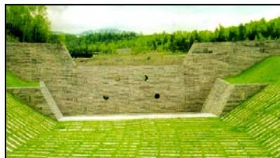
尻無沢川第2号ダム
