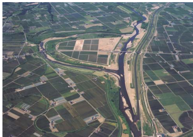
雨竜川捷水路
