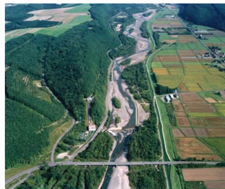
志比内橋 (KP25.80)付近
