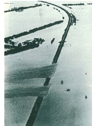
下新篠津築堤の破堤状況 写真出典：北海道開発局
