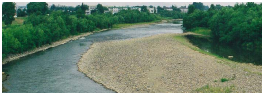
金星橋(KP158.00)付近
