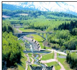
尻無沢川流路工
