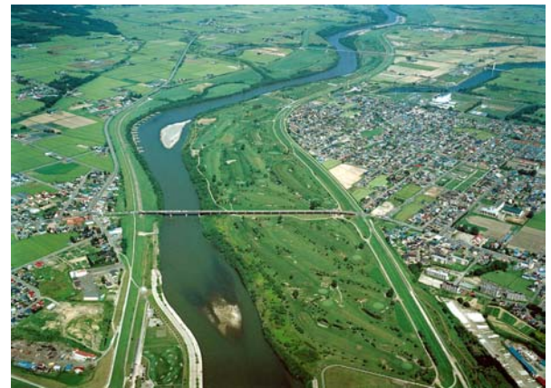
石狩川橋 (KP94.00) 付近
