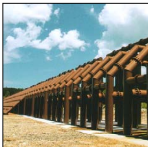
富良野川3号透過型ダム
