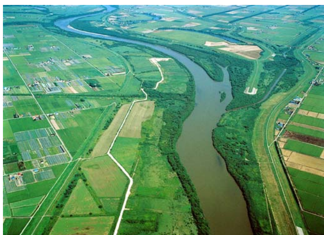
河岸の植生の状況 (KP63.00付近)
