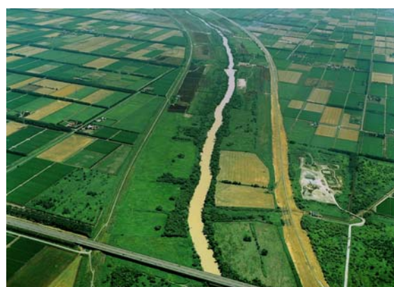
夕張川橋 (KP3.25) 付近
