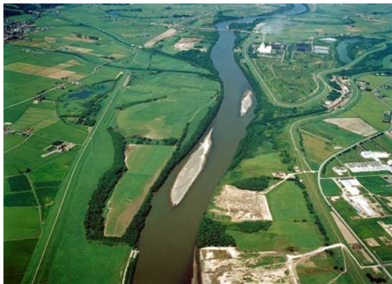
奈井江大橋 (KP76.80) 付近
