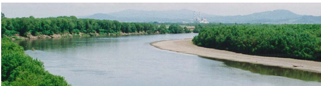
奈井江大橋(KP76.80)付近
