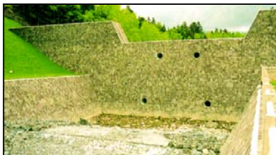
尻無沢川第1号ダム
