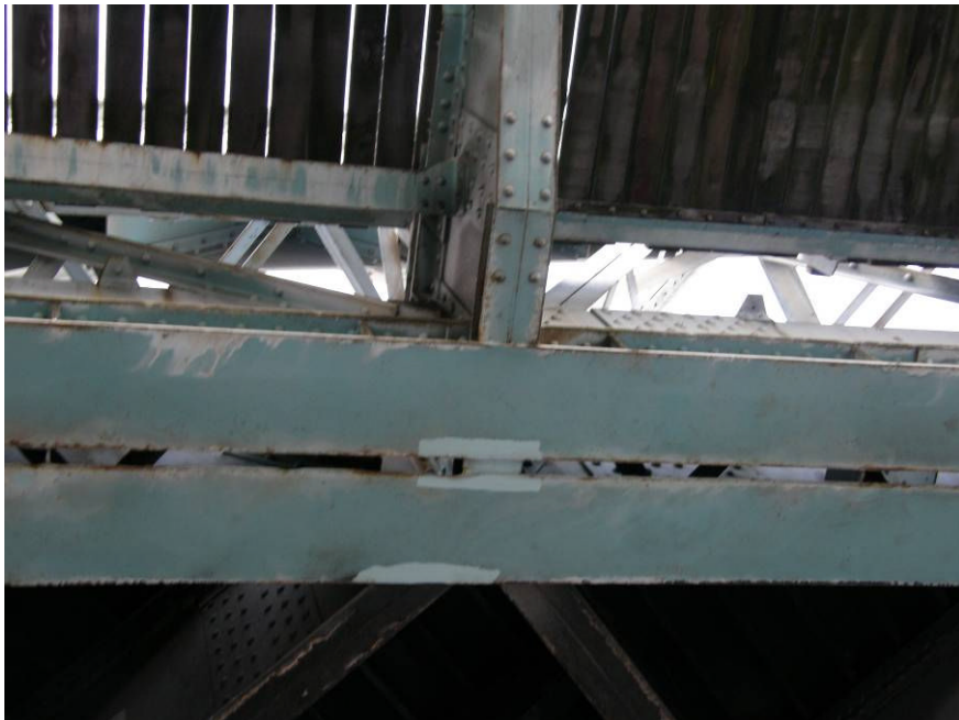
図 2-14 ロシュヴィツァー橋下面の状況 (補修痕あり)
