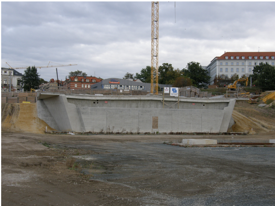
図 4-4 側径間とトンネルの接合部（北側）
