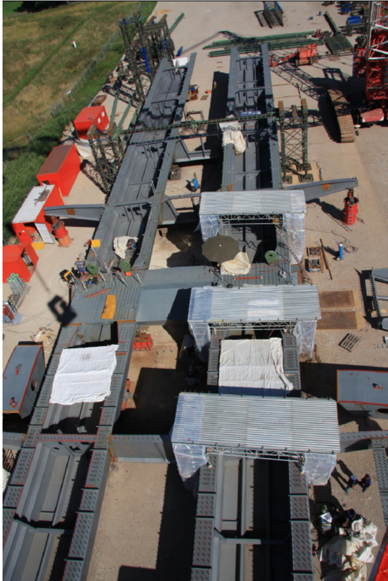
図 4-7 上部工部材の組み立て状況
