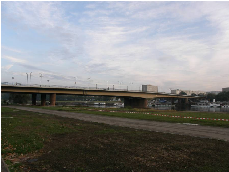
図 3-11 中心市街地にある PC 箱げた橋（カローラ橋、1970 年完成）
