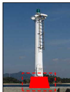
コンクリートで保護
