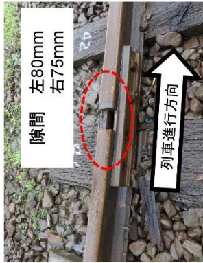
レール継ぎ目板 ボルト破損 (40k315m付近・左右とも)
