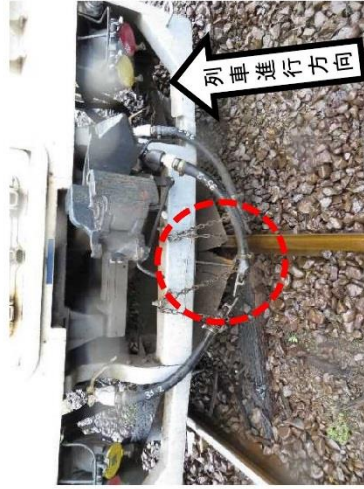
スノープラウ破損 (2両目 後尾)
