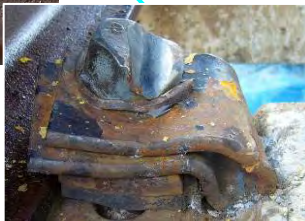
10b, 12bまくら木損傷の写真は 事故後、軌きょうを移動した後に撮影
