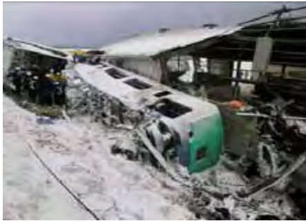
西側中央部分 (南西方向より撮影)
