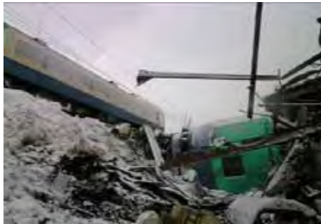
西側中央部分 (南方向より撮影)
