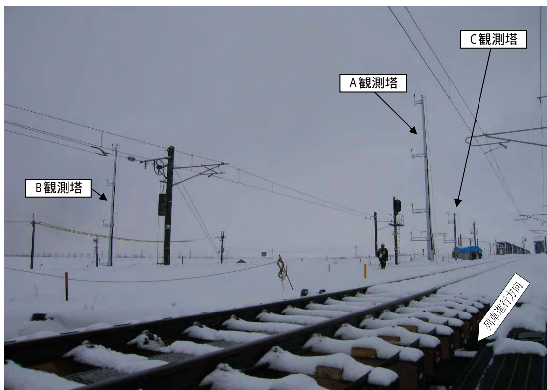
写真 2 事故現場付近の追加風速計
