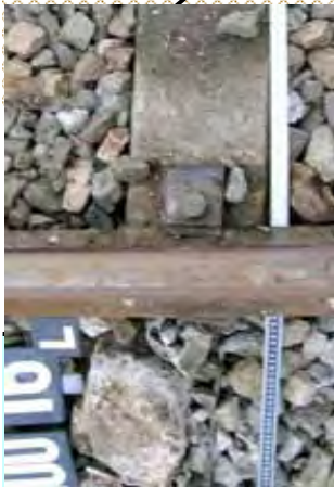
116まくら木の損傷 堆肥舎
