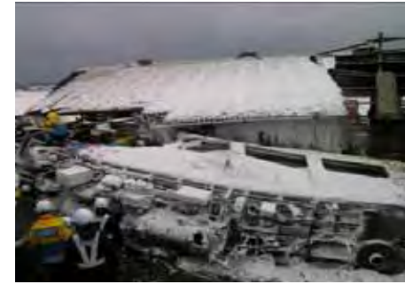
北西側の角部分 (西方向より撮影)
