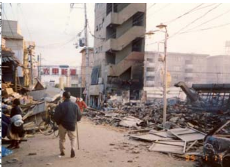
図 地区周辺の被災状況
