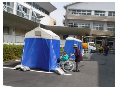
図 3-1-8 避難所に設置されたマンホールトイレ（熊本市）
