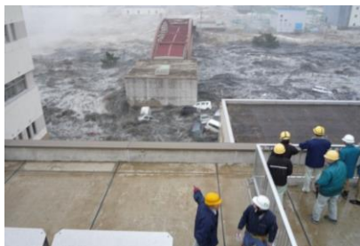
図 3-1-5 津波により浸水する南蒲生浄化センター（仙台市）
