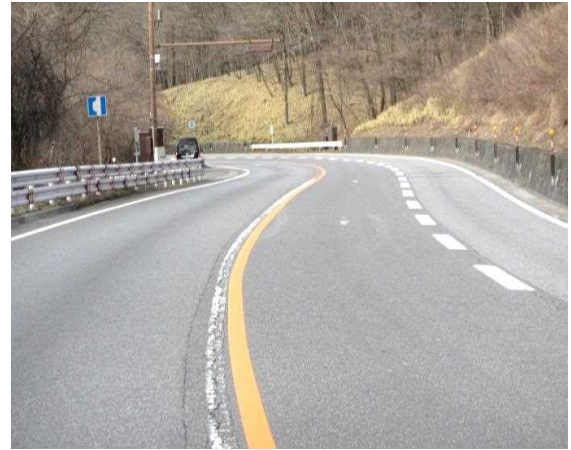
参考写真4 C40 から C41 を見る (約 500m手前)
