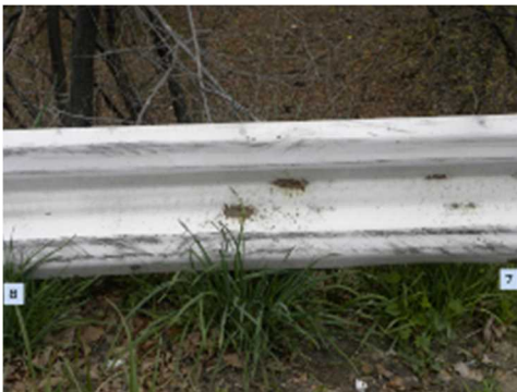
写真 25-3 ガードレール傷跡③
