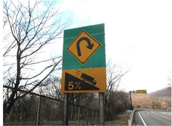
参考写真10 警戒標識等 (5%勾配) (約800m手前)
