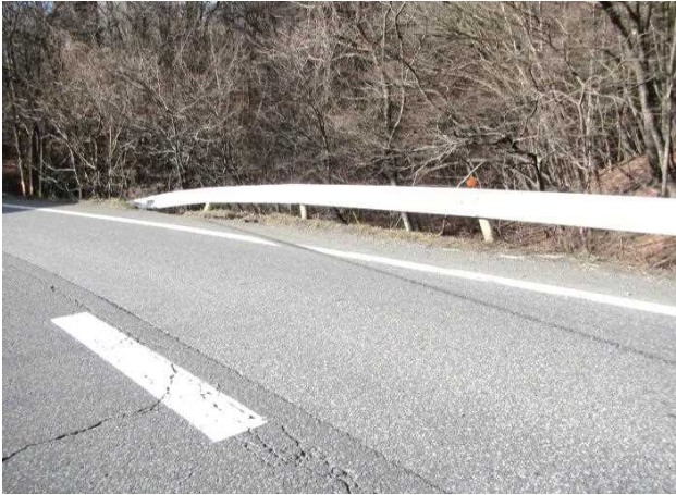
参考写真 19 転落地点その 1
