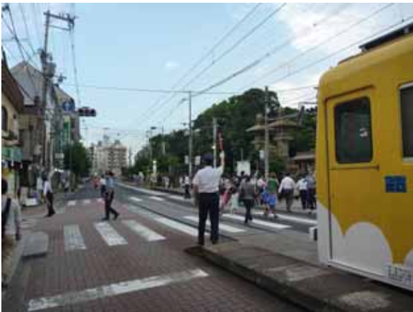
軌道横断箇所には交通誘導員を配置し、歩行者の横断を監視
