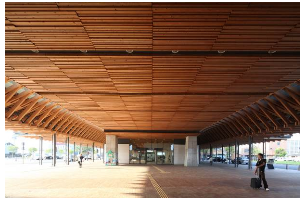
駅 1 階部分、コンコース天井の杉仕上げ材。断面の大きさの異なる部材を使用し天井に変化を与えている。
