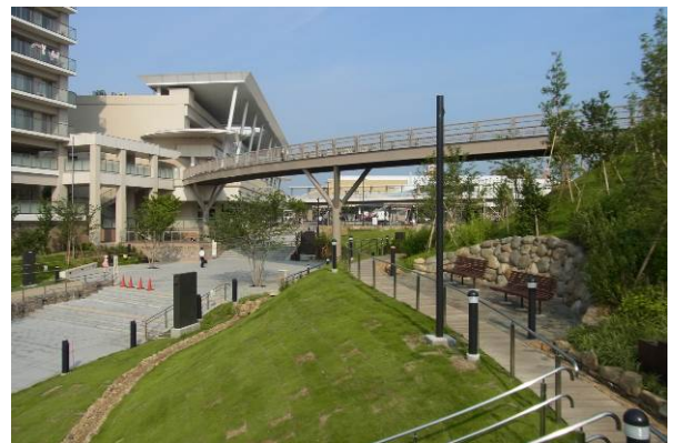
ゆるやかに弧を描きながら無理なく高低差を解消する市民広場の斜路とデッキ。
