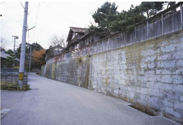
橋立は起伏に富む地形のため、笏谷石の石垣が至る所に見られる。
