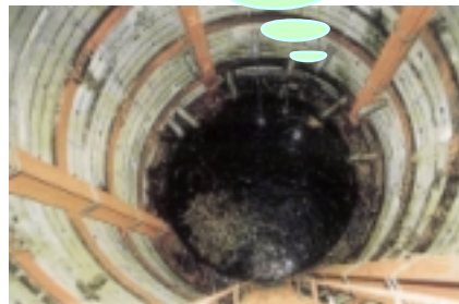
集水井を上からのぞいた様子
