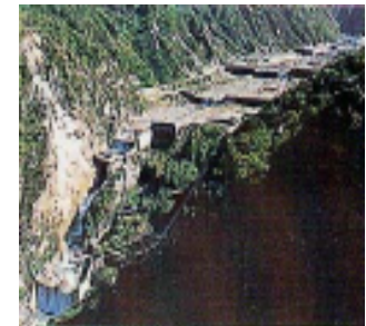
白岩砂防えん堤 (富山県)
