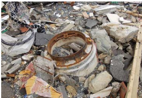
宮城県女川町（蓋の流出）
