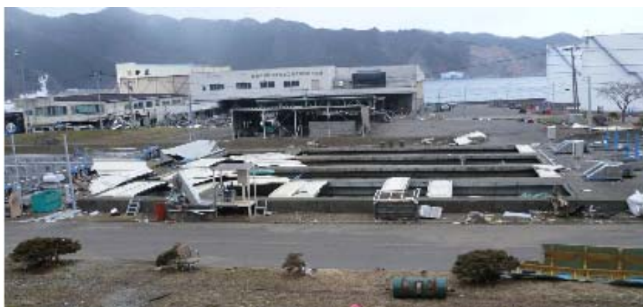
写真 3-2 大平下水処理場 (FRP 覆蓋の流出)
