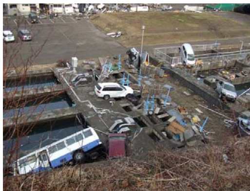
写真 3-5 大平下水処理場 (水処理施設への車両浸入)
