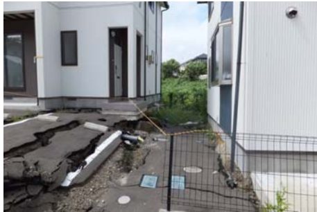
C地区における被害（沼の盛土の液状化による家屋被害）
