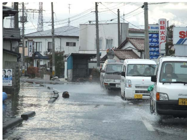
地盤沈下による道路冠水状況（1）
