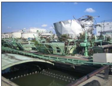
最初沈殿池にのりあげたガスタンク
