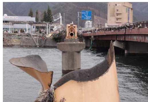
写真 2-5 岩手県釜石市 矢ノ浦水管橋被害状況
