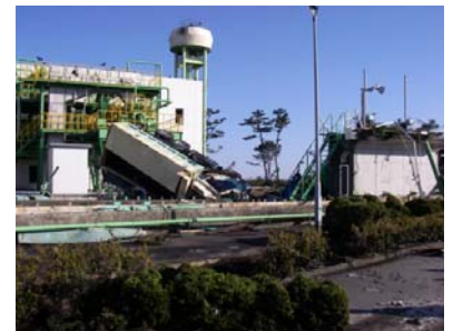
漂流車両による流入ゲート損傷
