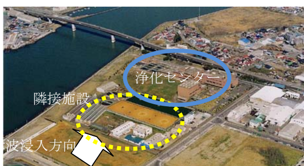
写真 3-6 石巻東部浄化センター (津波浸入方向に隣接施設有り)
