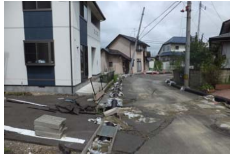
C地区における被害（沼の盛土の液状化による家屋被害）
