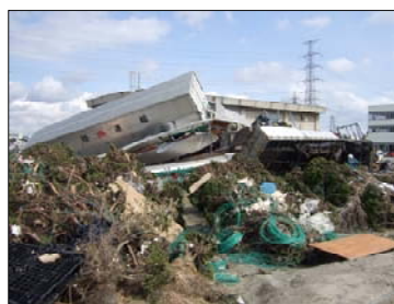
ポンプ場南西部車両漂流物
