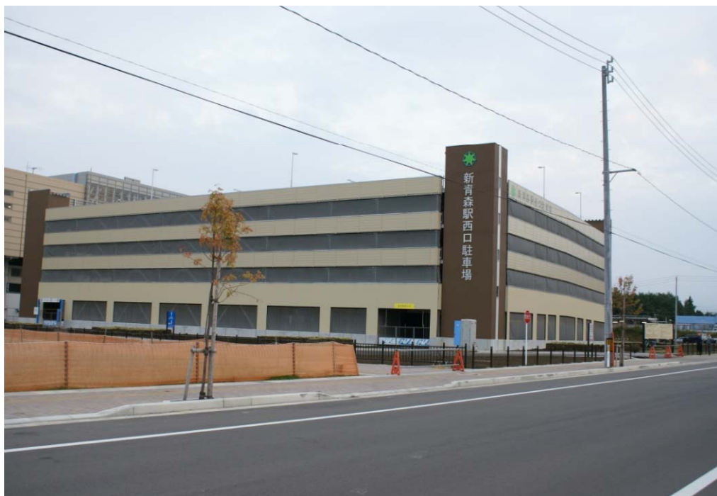
【新青森駅周辺 西口立体駐車場】 (約1000台の駐車スペースを提供、平成22年開業。)
