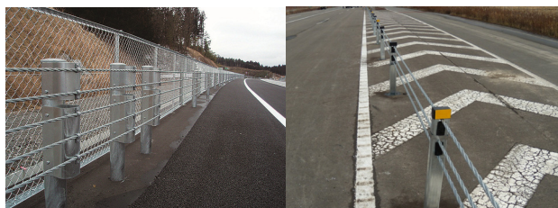
写真-1 ガードケーブル（左）とワイヤーロープ式防護柵（右）
