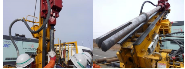
写真-13 アタッチメントの装着 (左) と装着後の状況 (右)
