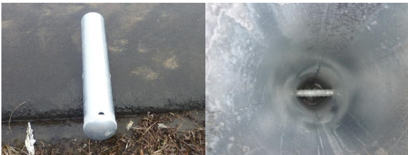
写真-12 スリーブ管 (左) と管内の支柱支え (右)
