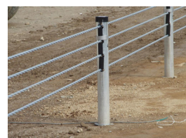
写真-6 新規開発の防護柵
