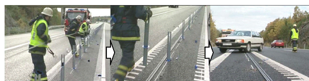
写真-4 緊急時の開放例 6)
