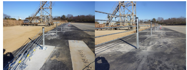
写真-9 再改良した防護柵の設置状況
