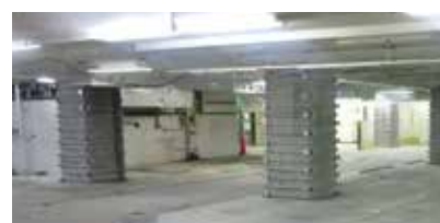
耐震補強工事実施済みの橋脚
