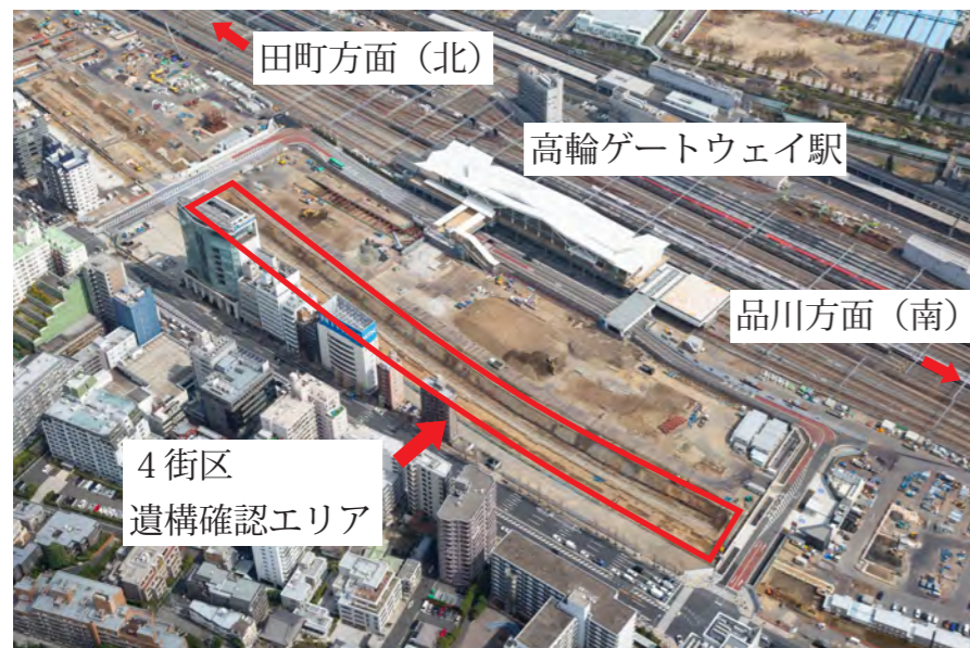
高輪ゲートウェイ駅上空から撮影。 JR 東日本提供航空写真
