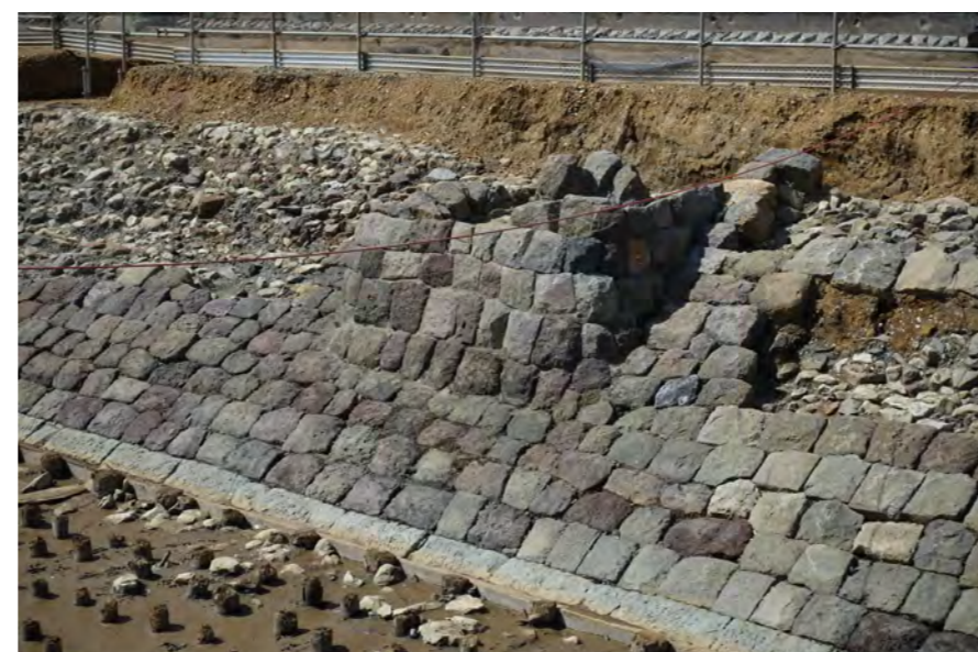
信号機跡と思われる張り出し部分。
