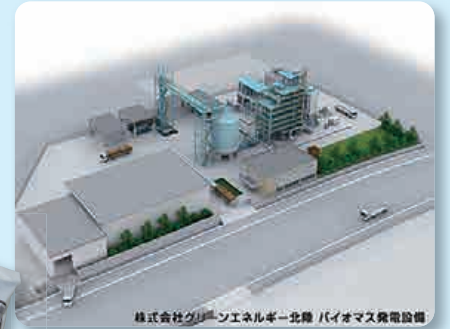
株式会社グリーンエネルギー北陸 バイオマス発電設備
