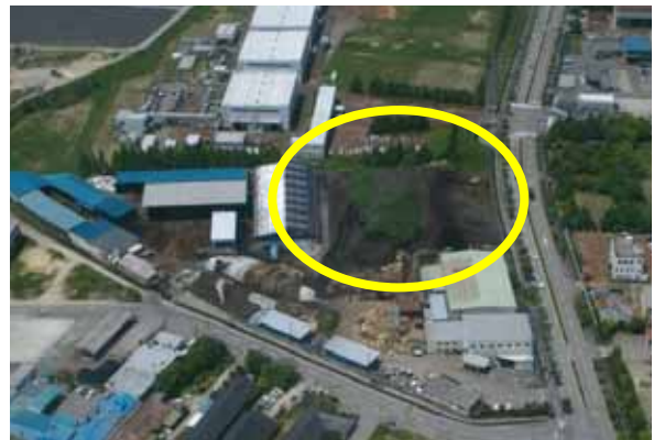
平成 22 年堆肥原料航空写真
