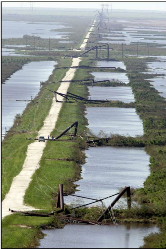
図 14.1. 嵐の被害を受けた高圧電線。配電設備は電力会社のアキレス腱である。フロリダ州、2004年9月
