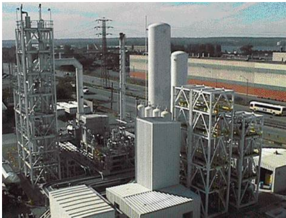
図 2.6. カナダ原子力公社、先進重水試験的生産工場、ハミルトン、オンタリオ州。この工場は1年間に約1トンの重水を生産した。大規模にすれば図 2.5 の古い工場より効率が良くて公害が少ない。写真はカナダ原子力公社提供。
