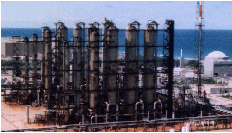
図 2.5. オンタリオ・ハイドロ・インターナショナル社のブルース岬重水生産所は年間 800 トンの生産能力があったが、1997年に閉鎖された。この規模の工場が八つあれば全世界のエネルギーを供給するだけの重水が抽出できる。写真はカナダ原子力公社提供。
