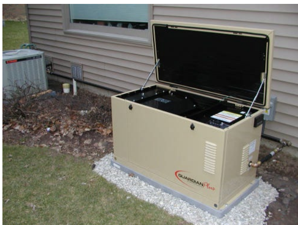
Fig. 14.3. 窓のそばに置かれた7キロワットの家庭用の予備発電機。左に冷房機が見える。20キロワットの常温核融合の発電機はほぼこの大きさになるだろう。写真：D. Kontac, Amazon.com.
