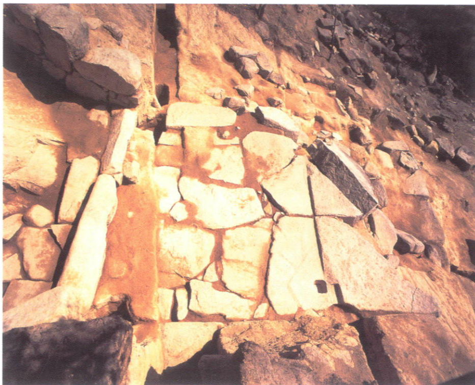
2. 東門 門道 (南西から)
